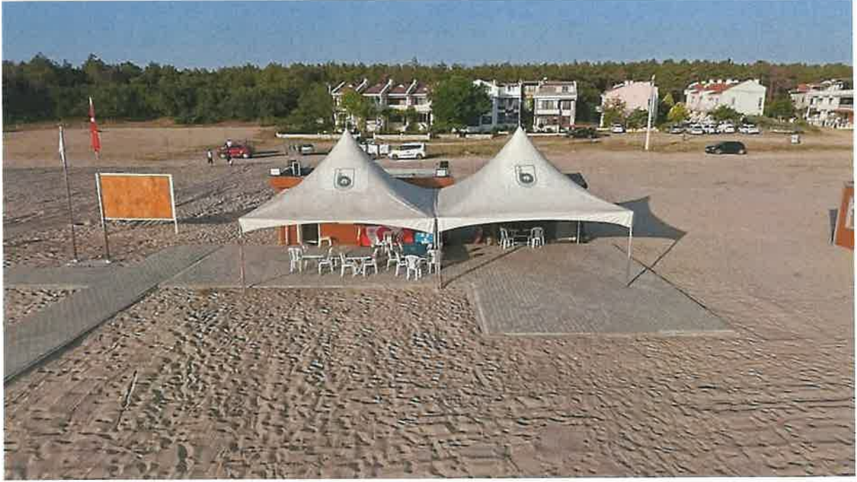
Metruk binaların yıkım ve temizlik işlemleri gerçekleştirilmiştir.
